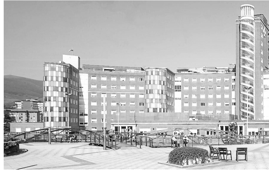
Hospital de Cruces del arquitecto Martín José Marcide (1949-1953),
