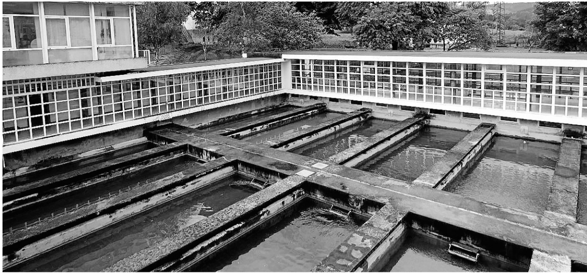
Estación Depuradora de Aguas de los arquitectos Juan de Madariaga y Lander Gallastegui de 1962-66.
